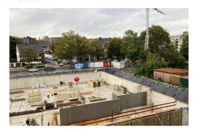
Im dritten Quartal 2021 wurden zunächst die erforderlichen Gründungs- und Erdarbeiten für die neue **Sporthalle** abgeschlossen. Die Rohbauarbeiten haben begonnen und die Stahlbeton-Bodenplatte ist weitestgehend fertiggestellt. Die Arbeiten zur Herstellung der Stahlbeton-Wände wurden begonnen und werden nun weiter fortgesetzt. Alle erforderlichen Arbeiten zum Fluchttreppenturm am Bestandsgebäude im Bereich der NW-Räume wurden im Laufe der Herbstferien weitestgehend abgeschlossen.
